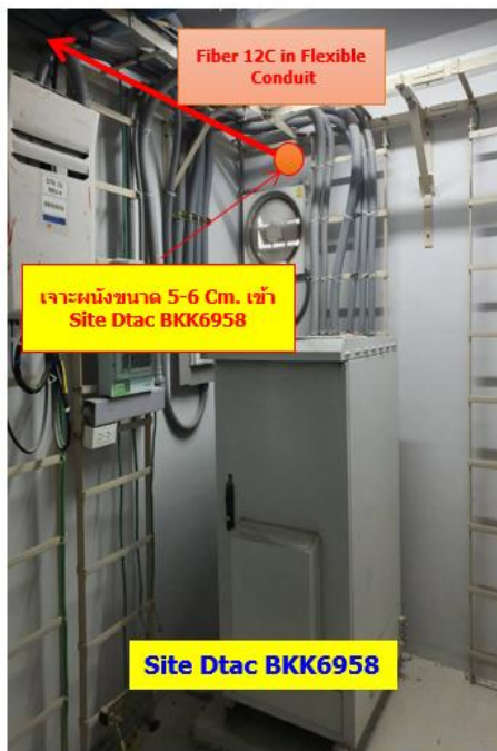
รูป 44 การติดตั้งระบบ Transmission ของ DTAC ให้สถานีฐาน 5G ที่ใช้สำหรับการทดสอบกรณี Outdoor
