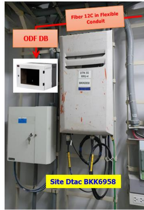
รูป 44 การติดตั้งระบบ Transmission ของ DTAC ให้สถานีฐาน 5G ที่ใช้สำหรับการทดสอบกรณี Outdoor
