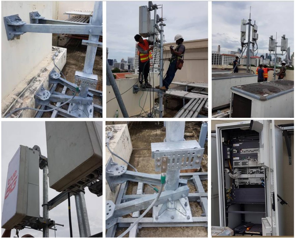
รูป 43 การติดตั้งสถานีฐาน 5G ที่ใช้สำหรับการทดสอบกรณี Outdoor
